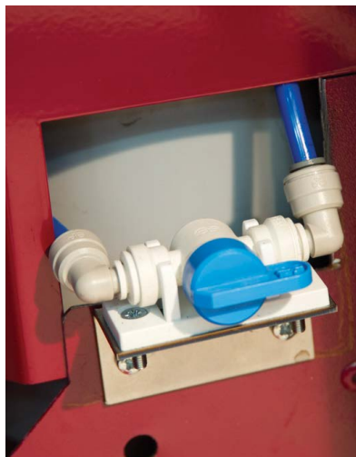
Zawór pompy wody
